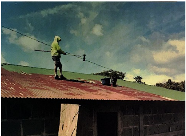
Das Dach am Kooperativenhaus der Coop. Guardabarranco wird gestrichen / abgedichtet.
